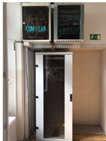
Slika 7 do 8: Obstoječi telefonski delilnik, ter glavno komunikacijsko vozlišče V objektu je izvedena bolnišnična signalizacija.
