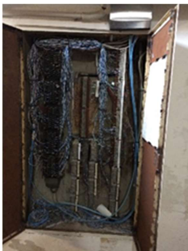
Slika 7 do 8: Obstoječi telefonski delilnik, ter glavno komunikacijsko vozlišče V objektu je izvedena bolnišnična signalizacija.
