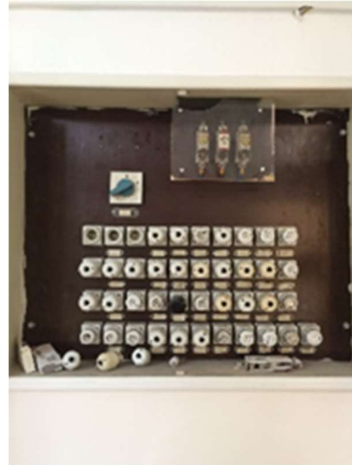
Slika 5 do 6: Obstoječi etažni razdelilnik za razvod el. Energije
